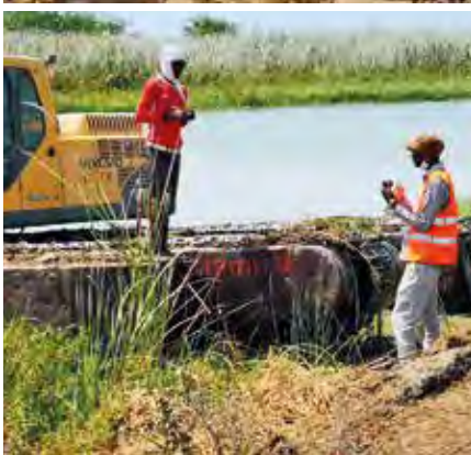
^ Travaux de curage du marigot
