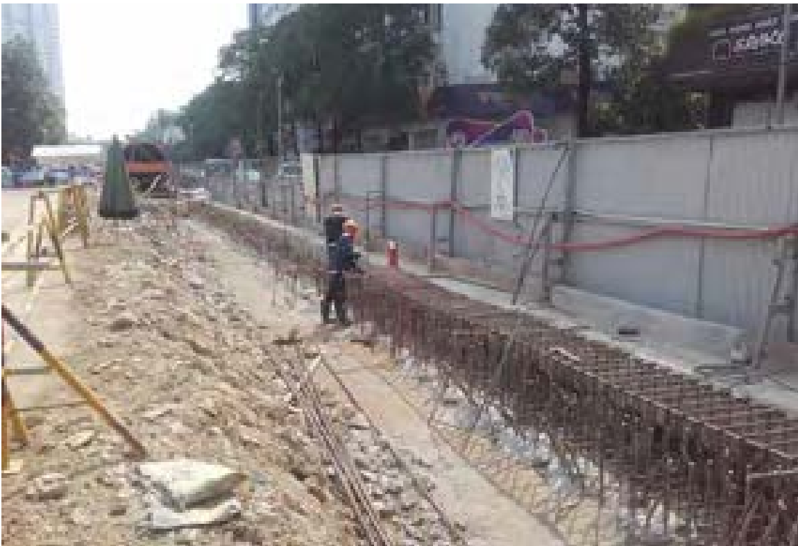
Construcción de la línea piloto de metro nº 3 - Hanoi
