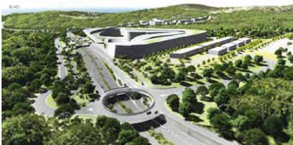
Infraestructuras primarias en la zona de desarrollo concertado de Clausonnes - Valbonne
