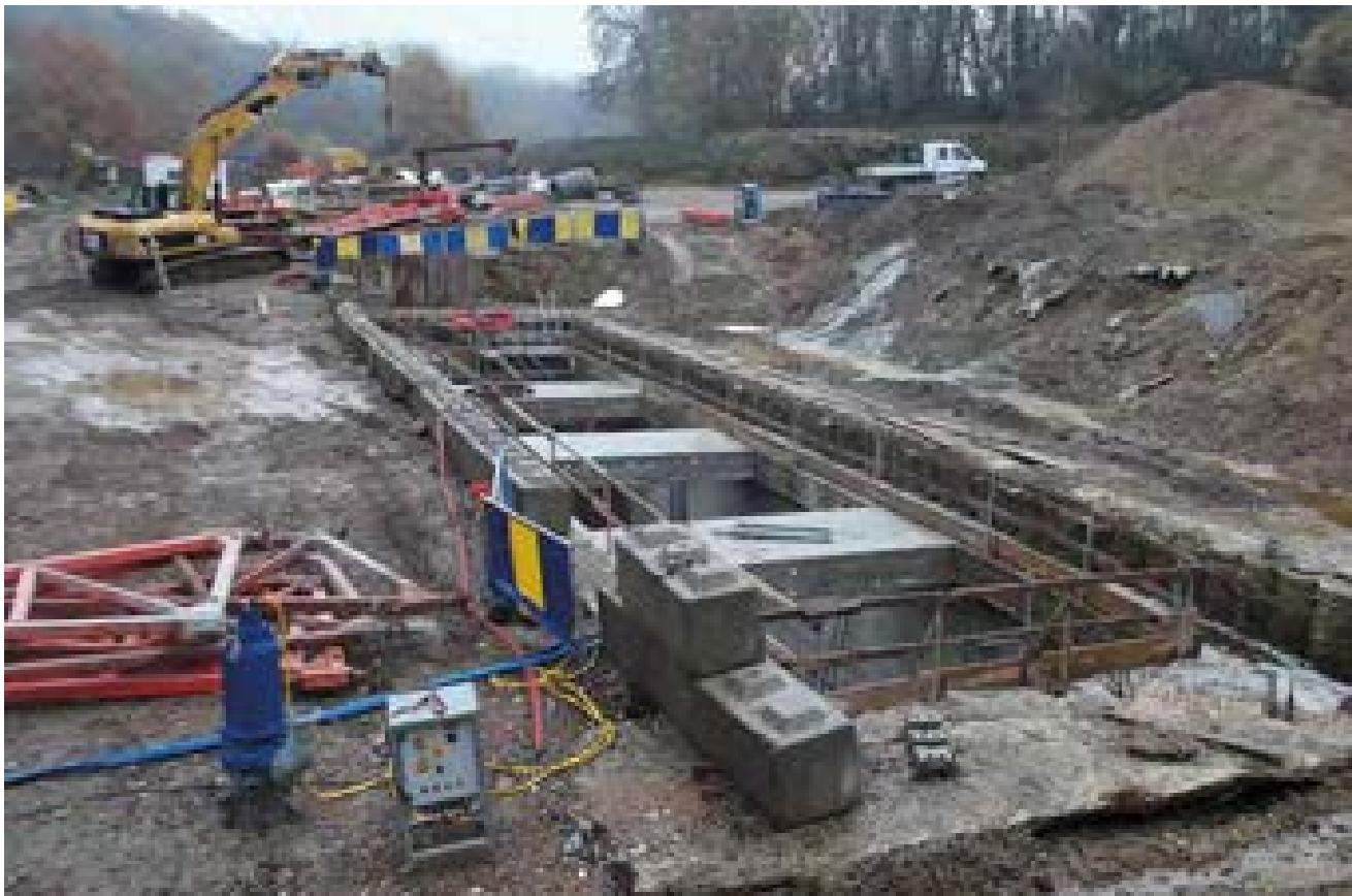
Nuevo colector- Valle Verrewinkelbeek (Bruselas)
