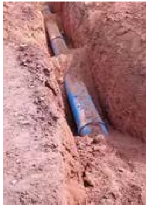
Instalación de tuberías de fundición dúctil
