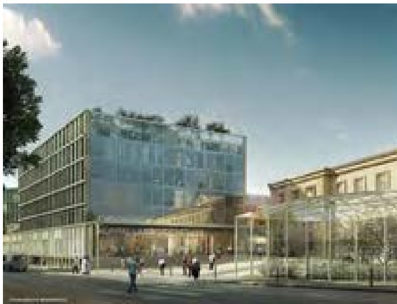
Reforma y ampliación del Hospital Lariboisière de París (Francia)
