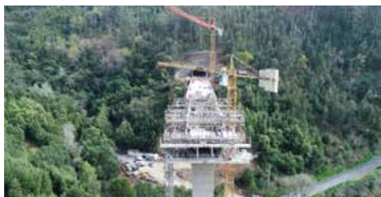
Autopista Fajã da Ovelha- Ponta do Pargo / Portugal
