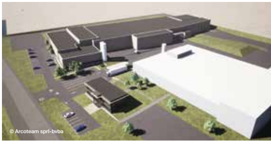
Fábrica AVIETA, Vinalmont / Bélgica
