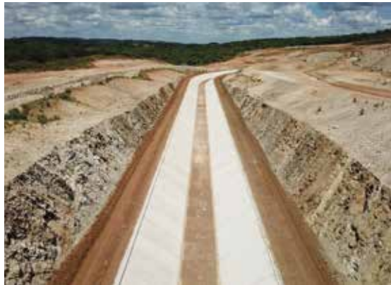
Vista aérea del sistema de abastecimiento de agua Ramal do Agreste /Brasil
