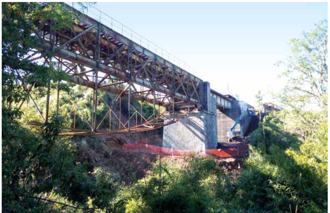
Rehabilitación y refuerzo de un puente del Grupo 5
