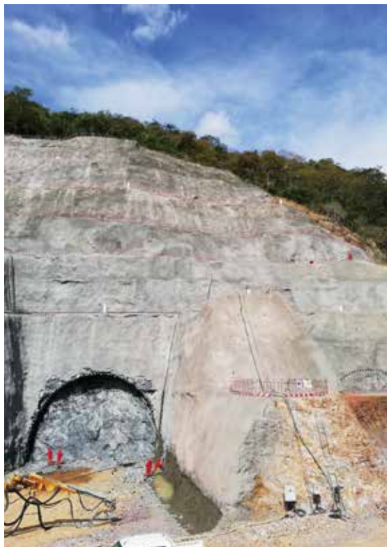
Proyecto hidroeléctrico Caculo Cabaça
