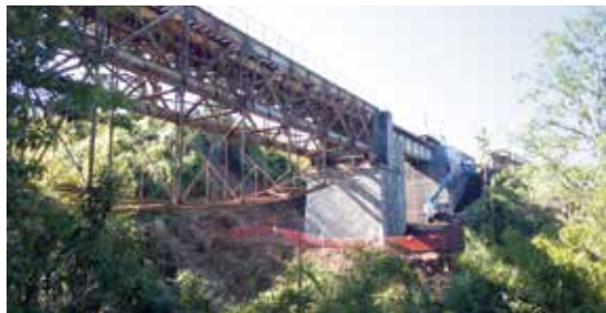
Puente del Grupo 5 / Chile
