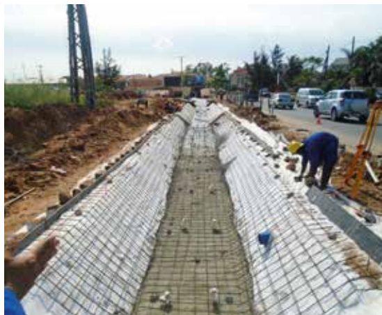
Rehabilitación de obras prioritarias de drenaje en Maputo
