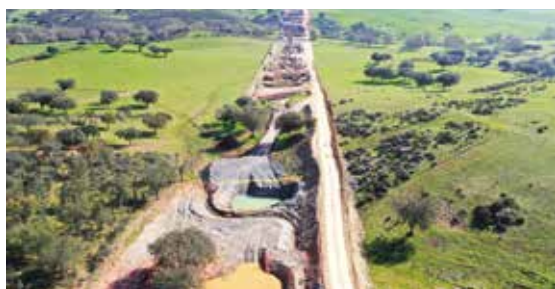
Enlace ferroviario entre Évora y la Línea del Este / Portugal
