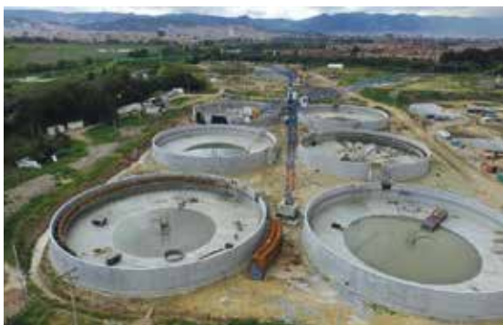
← Ampliación de la estación de tratamiento de aguas residuales El Salitre en Bogotá
