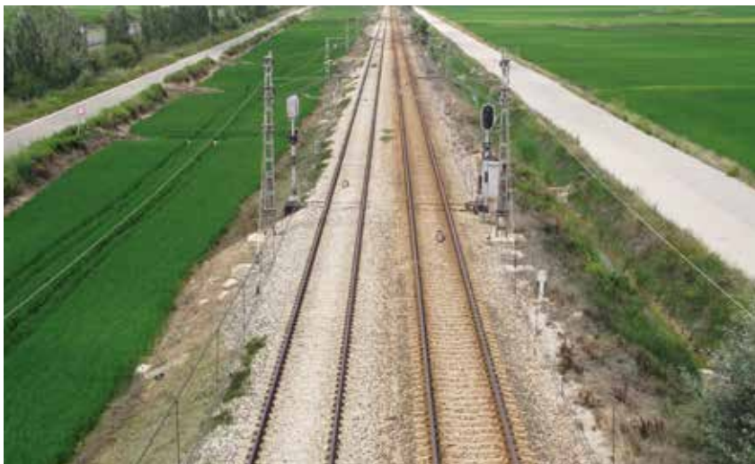
Modernización del tramo Silla-Cullera de la línea que conecta Gandía y Silla
