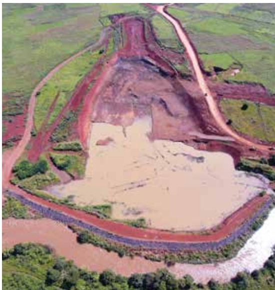
← Obras de construcción del desarrollo hidroeléctrico de Bini en Warak
