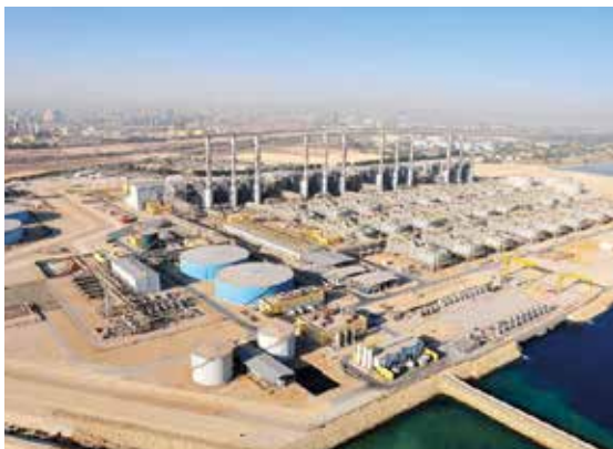
Planta desaladora de agua de mar en Les Mamelles, Dakar / Senegal
