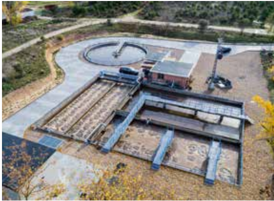
Estación de Tratamiento de aguas residuales UAM Madrid / España
