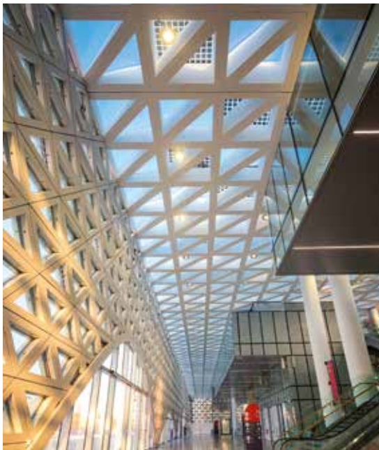
Nueva estación de tren de Kenitra
