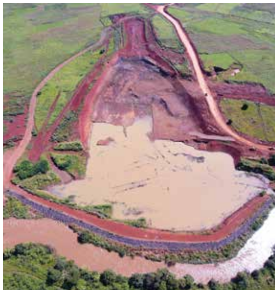
← Construction de l'aménagement hydroélectrique de Bini à Warak
