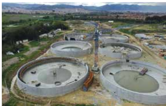
← Extension de la station de traitement des eaux usées El Salitre à Bogotá
