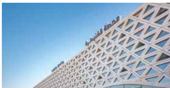
Gare ferroviaire de Kénitra / Maroc
