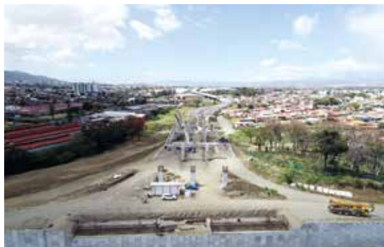
Viaduc - périphérique Nord de San José
