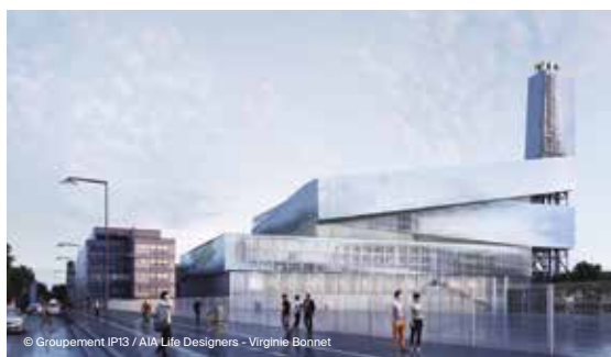
Centre de valorisation des déchets Ivry-Paris XIII
