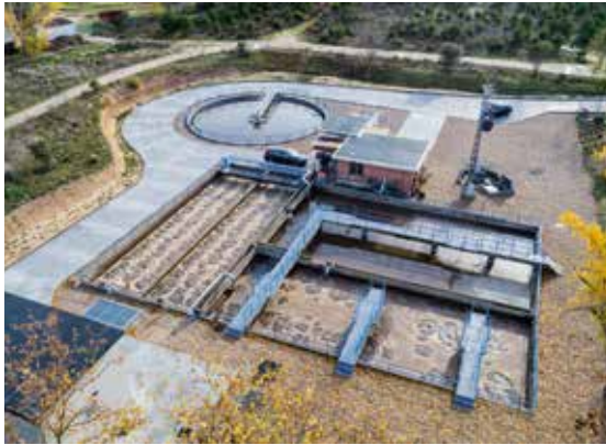
Station de traitement des eaux usées UAM, Madrid / Espagne
