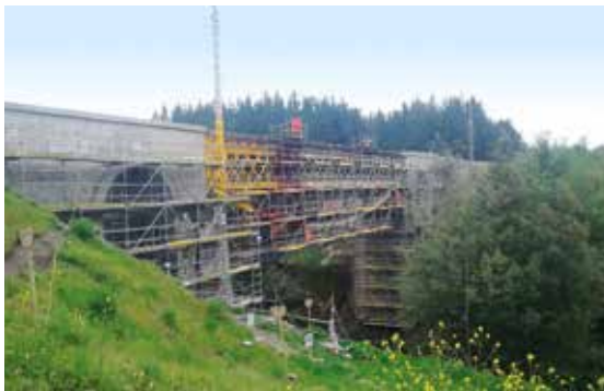
← Réhabilitation et renforcement d'un pont du groupe 2
