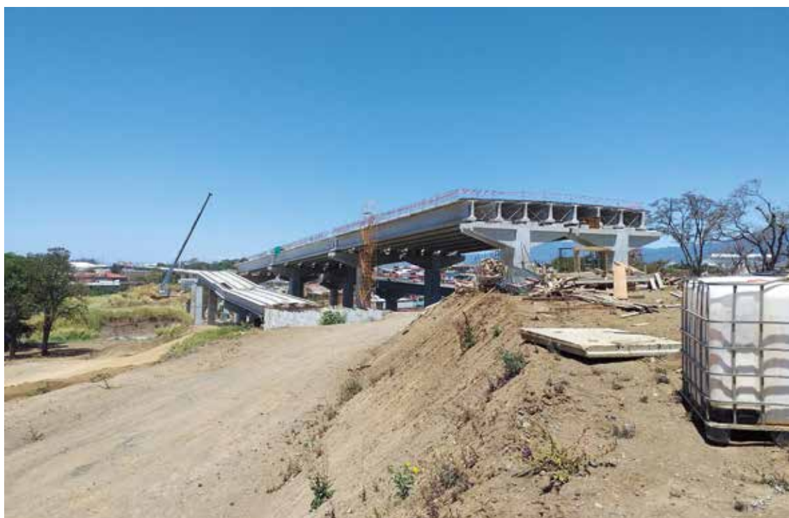
Viaduc et rampe à l'échangeur trois niveaux de la Nationale 32
