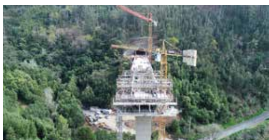
Voie express Fajã da Ovelha – Ponta do Pargo / Portugal
