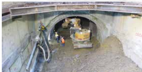
Extension de la ligne 1 du métro d'Alger / Algérie
