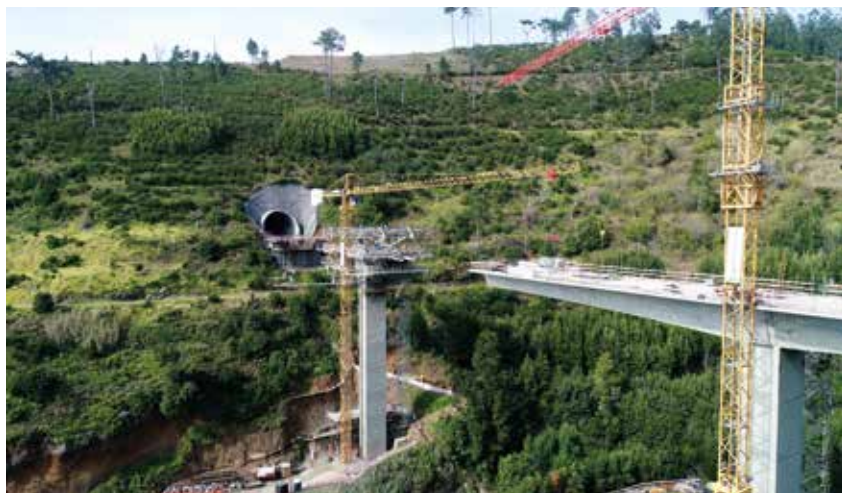
Voie express Fajã da Ovelha - Ponta do Pargo (Madère)
