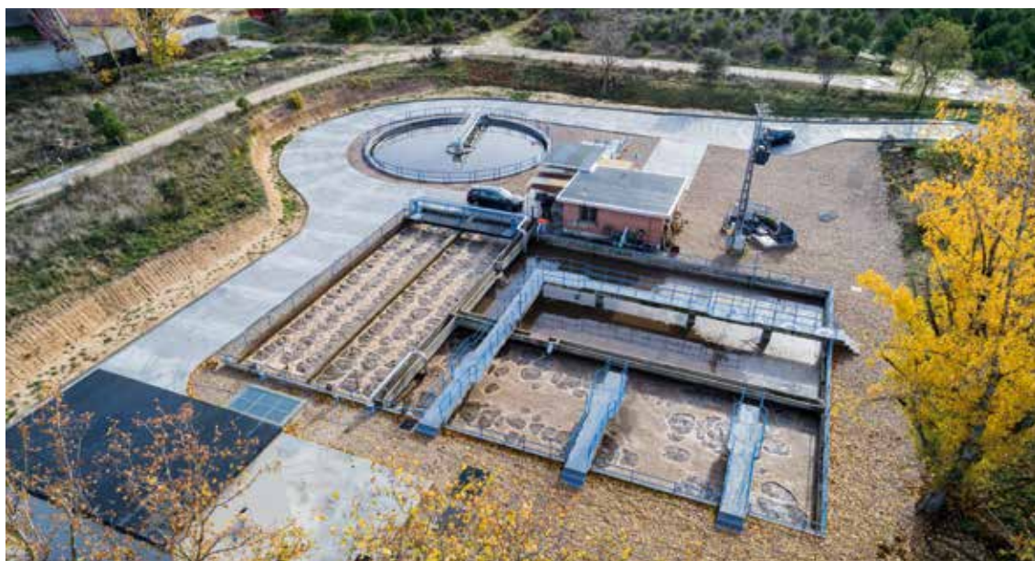
Station de traitement des eaux usées desservant l'Université Autonome de Madrid (UAM)
