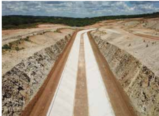
Vue aérienne du système d'adduction d'eau « Ramal do Agreste » / Brésil
