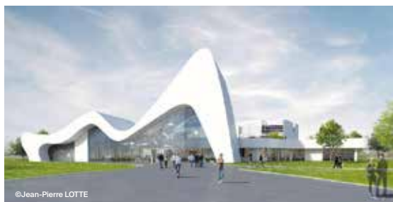
ESTP, Rosières-Près-Troyes / France
