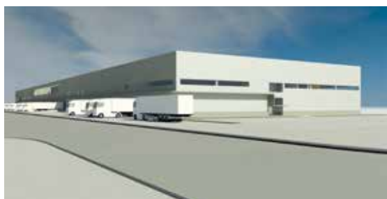
Entrepôt de stockage et de distribution de produits ali- mentaires surgelés et siège central du groupe Caprabo, Barcelone / Espagne
