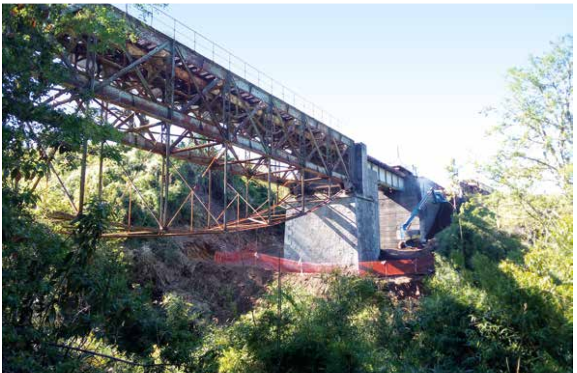
Réhabilitation et renforcement d'un pont du groupe 5
