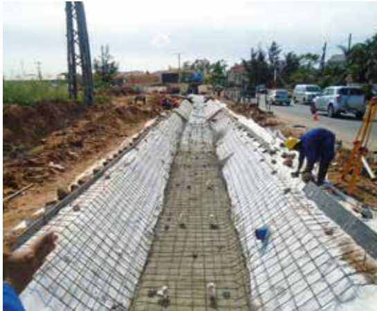
Réhabilitation des ouvrages prioritaires de drainage de Maputo
