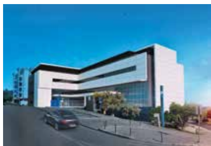
Hospital CUF Torres Vedras /Portugal
