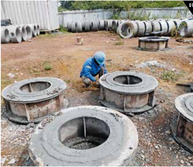
01 — Rede de abastecimento de água à cidade de Mongono / Edifícios técnicos
