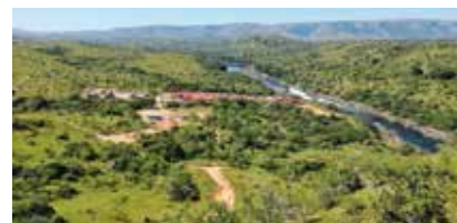
Local da futura estação de tratamento de Capari / Angola
