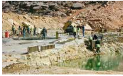
Barragem de Seguelil, Adrar / Mauritânia
