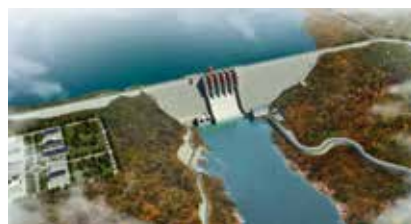
Projeto de aproveitamento hidroelétrico de Caculo Cabaça / Angola
